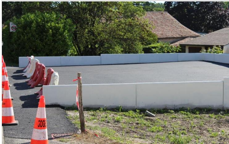
Après les travaux de démolition, la réalisation du parking avec construction d'un mur de soutènement, traitement des eaux pluviales et les enrobés sont terminés. Reste à finaliser début juillet, le traçage en peinture des 8 emplacements et le plateau ralentisseur qui servira également de passage piétons.
