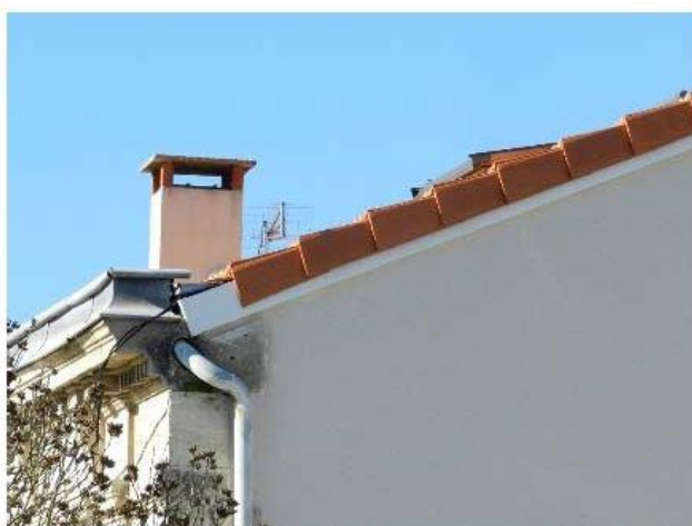
Tuile à rabat en L inadaptée aux travaux de restauration
