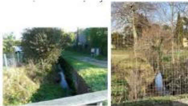
Le Batan, canalisé à la hauteur du bourg rue du lavoir (photo à gauche), le Batan en amont du bourg (photo à droite)
